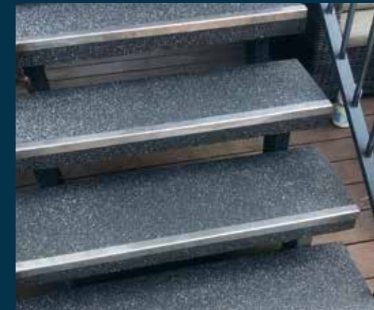
Treppenbeschichtung inkl. Verblendung
